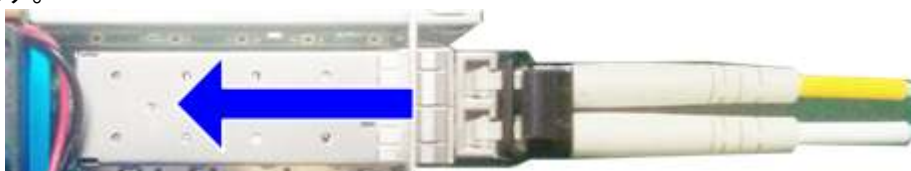
図 3-2:SFP+ケーブルの接続
